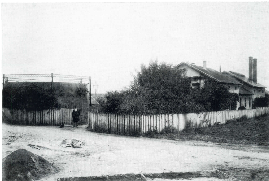
Die Gasanstalt Kirchheimbolanden im Jahre 1878 mit dem ersten Gaskessel von 150 cbm Inhalt. Im Vordergrund steht der Direktor der Gasgesellschaft Herr Philipp Schach.
