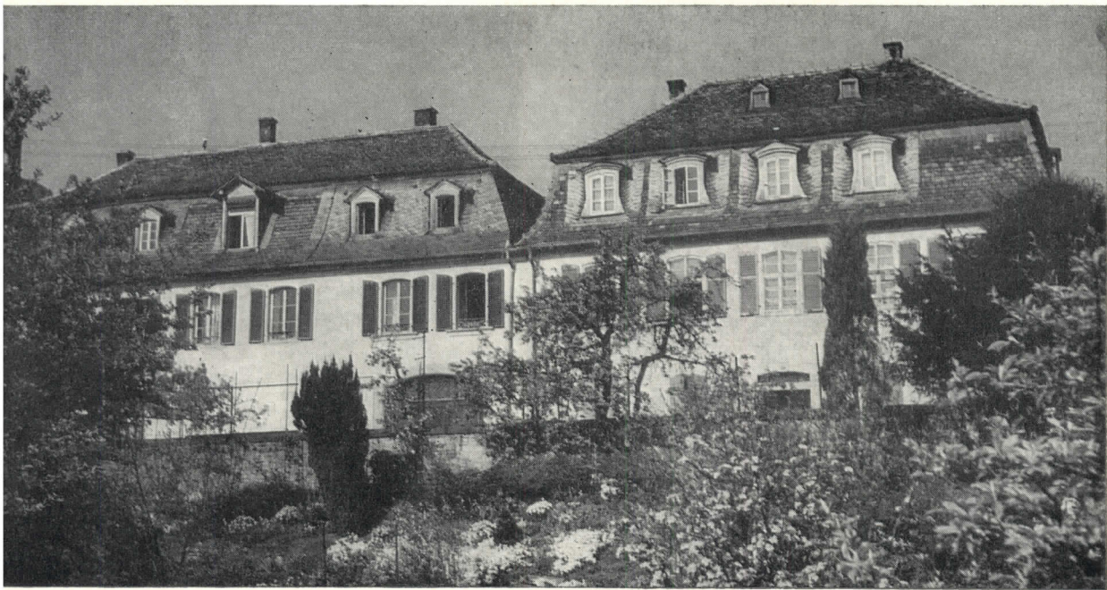
Kavaliershäuser in der Neuen Allee
