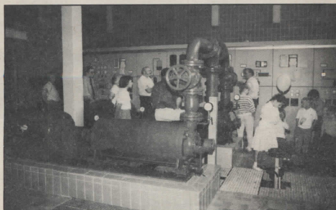
Wasserwerk Oberwiesen, Pumpenraum
