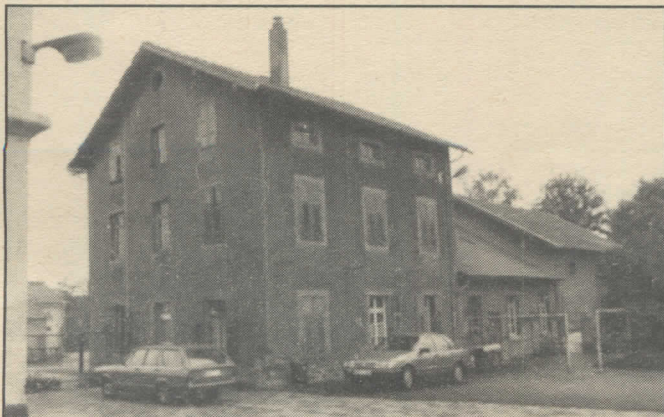
Das Gebäude der Verbandsgemeindewerke vor dem Abriß...
