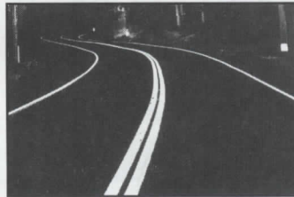
Gleiche Landstraße mit reflektierender Mittel- u. Randmarkierung
