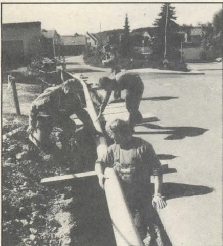
Zur Zeit wird eine neue Gasleitung im Ortsteil Haide, Hauptstr., Frankenstr. und Rothenkircher Weg verlegt. Mit dieser Maßnahme wird die Haide in die öffentliche Gasversorgung mit eingeschlossen.
