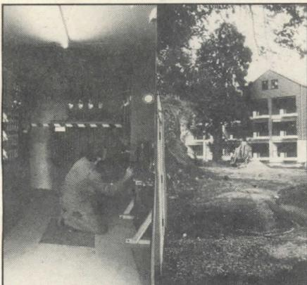
In der Karl-Fittler-Str. wurde eine neue Trafostation aufgestellt. Diese Trafostation ist mit einem Trafo 630 KVA bestückt und versorgt das Altenheim und die angrenzenden Anwesen mit elektrischer Energie.
