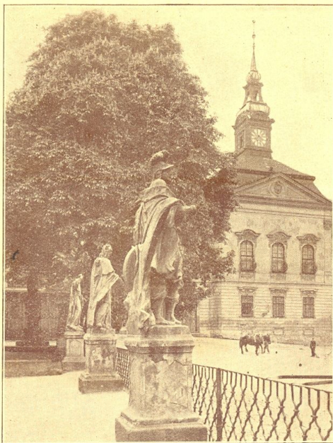
Bývalá stavovská sněmovna, skvělá baroková stavba z konce 17. neb počátku 18. století.
