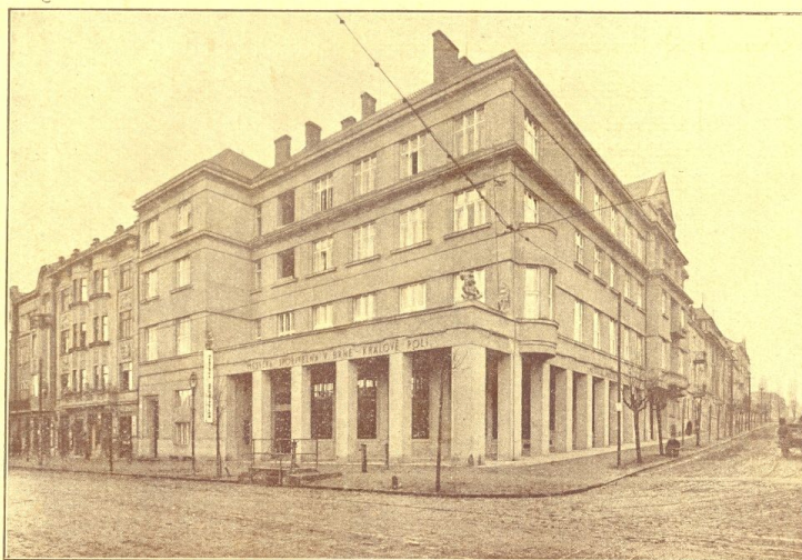
Budova ústředny v Král. Poli, Palackého tř. 28a.
