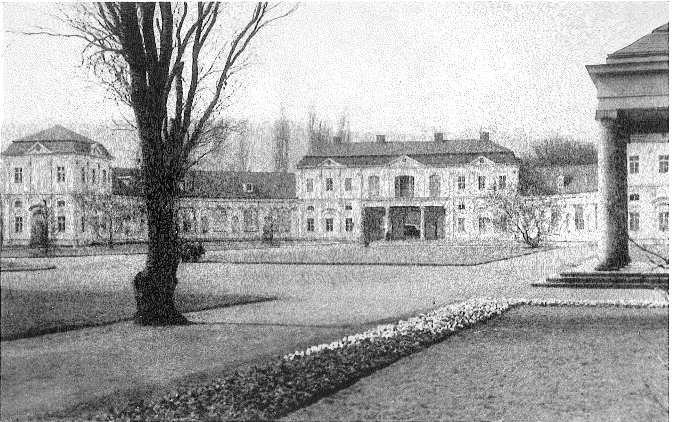
Ehemaliger Küchengarten mit Orangeriegebäude. In den Jahren 1729/32 in Anlehnung an die damaligen Lustgärten errichtet, wird die gesamte Bananlage nach vollständig durchgeführtem dringenden Umbau und nach Überholung als Museum der revolutionären Arbeiterbewegung des Bezirkes Gera eingerichtet.
