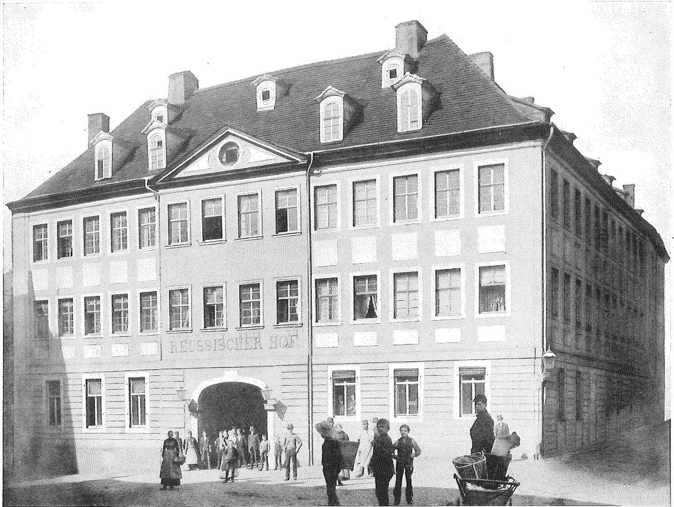
Der 1890 beim Bau der Rudolf-Ferber-Straße abgerissene größte Gasthof in alter Zeit: der „Reußische Hof“, vorher „Grüner Baum“, vor 1628 „Göldener Ring“ genannt. In ihm wohnte Eduard v. Winterstein mit Mutter und Schwester während seines Geraer Aufenthaltes 1889 und 1890. Hier übernachtete Goethe mehrmals.
