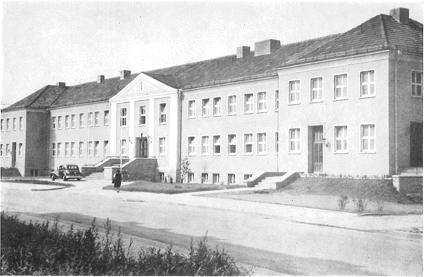
Der 1955 fertiggestellte Neubau der Poliklinik Zwätzen, alle wesentlichen Abteilungen umfassend
