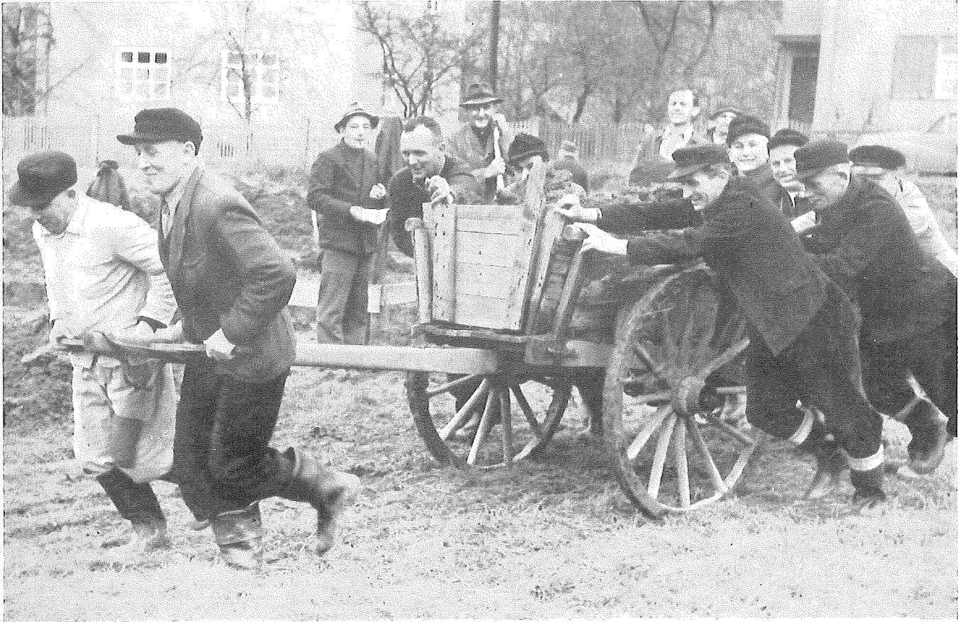
(78) Aber auch beim Hausneubau verbiess die Freundschaftsbilfe schnellere Fertigstellung, 1196 Wohnungen konnten instand gesetzt werden
