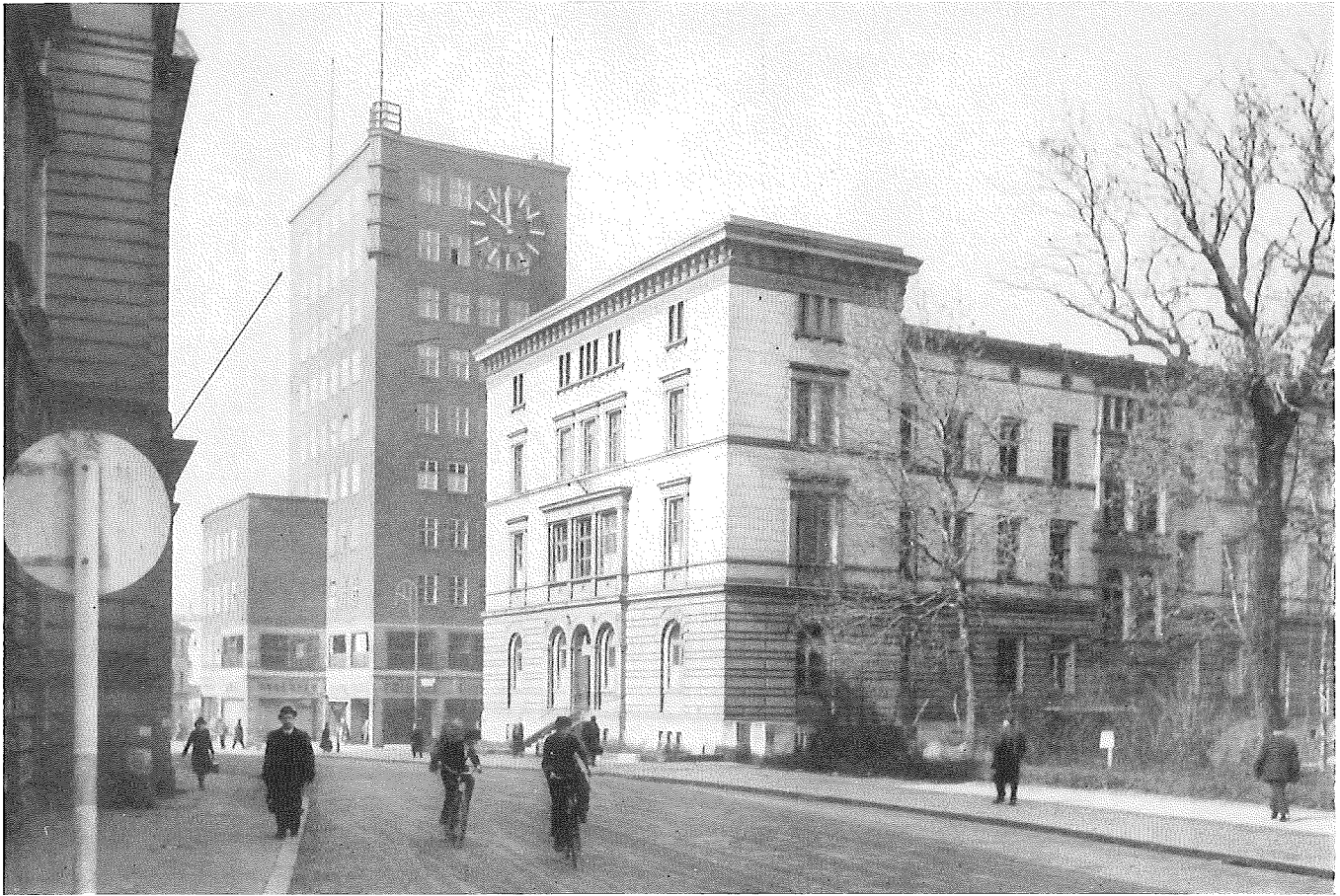
Blick auf das im Jahre 1928/29 mit teilweise 10 Stockwerken und Paternosteraufzug erbaute Hochbaus, das heute Sitz des Rates des Bezirkes Gera ist.
