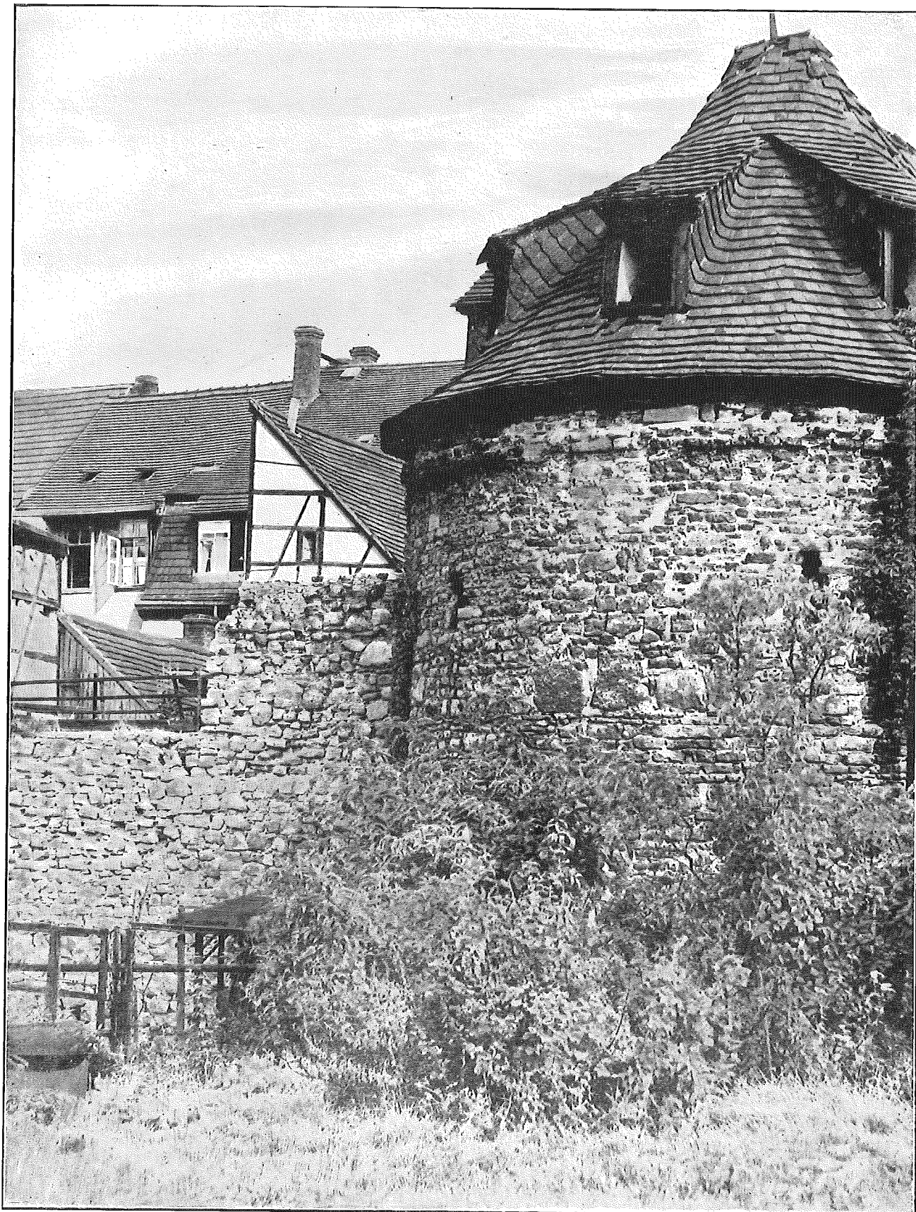
Stadtmauerturm mit Resten der Stadtmauer im Stadtgraben. Es ist der letzte 8 m hohe Rundturm der im Bruderkrieg zerstörten und nach 1450 wiederaufgebauten Stadtbefestigung, die der Bauperiode der Gotik zugehört. (6)
