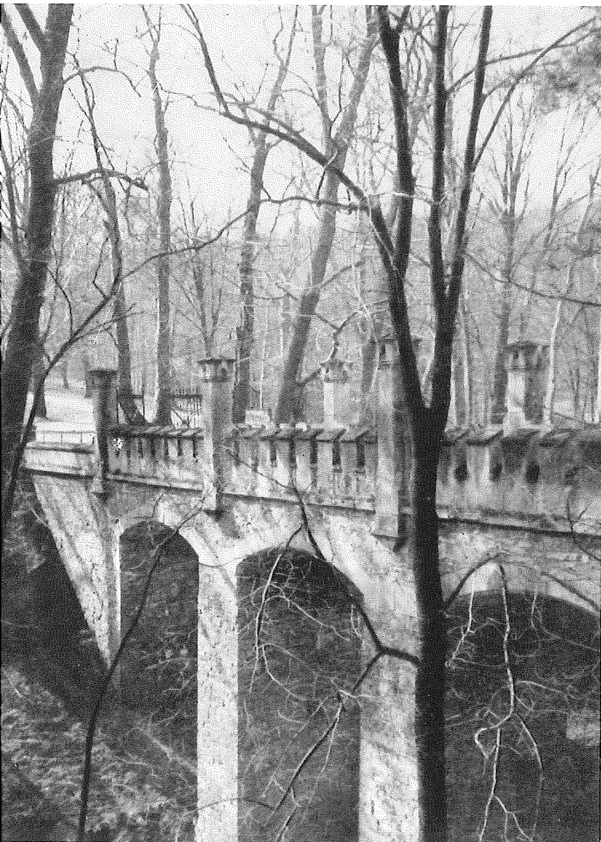
Die „Wolfsbrücke“, ehedem ein holzverkleideter Brückengang an der Südseite des Schlosses Oster- stein, wurde 1863 mit vier Bogen und Zinnen- brüstung über den erst 1857 hergestellten neuen Fahrweg umgebaut. Hier befand sich der älteste Schloßzugang. (44)
