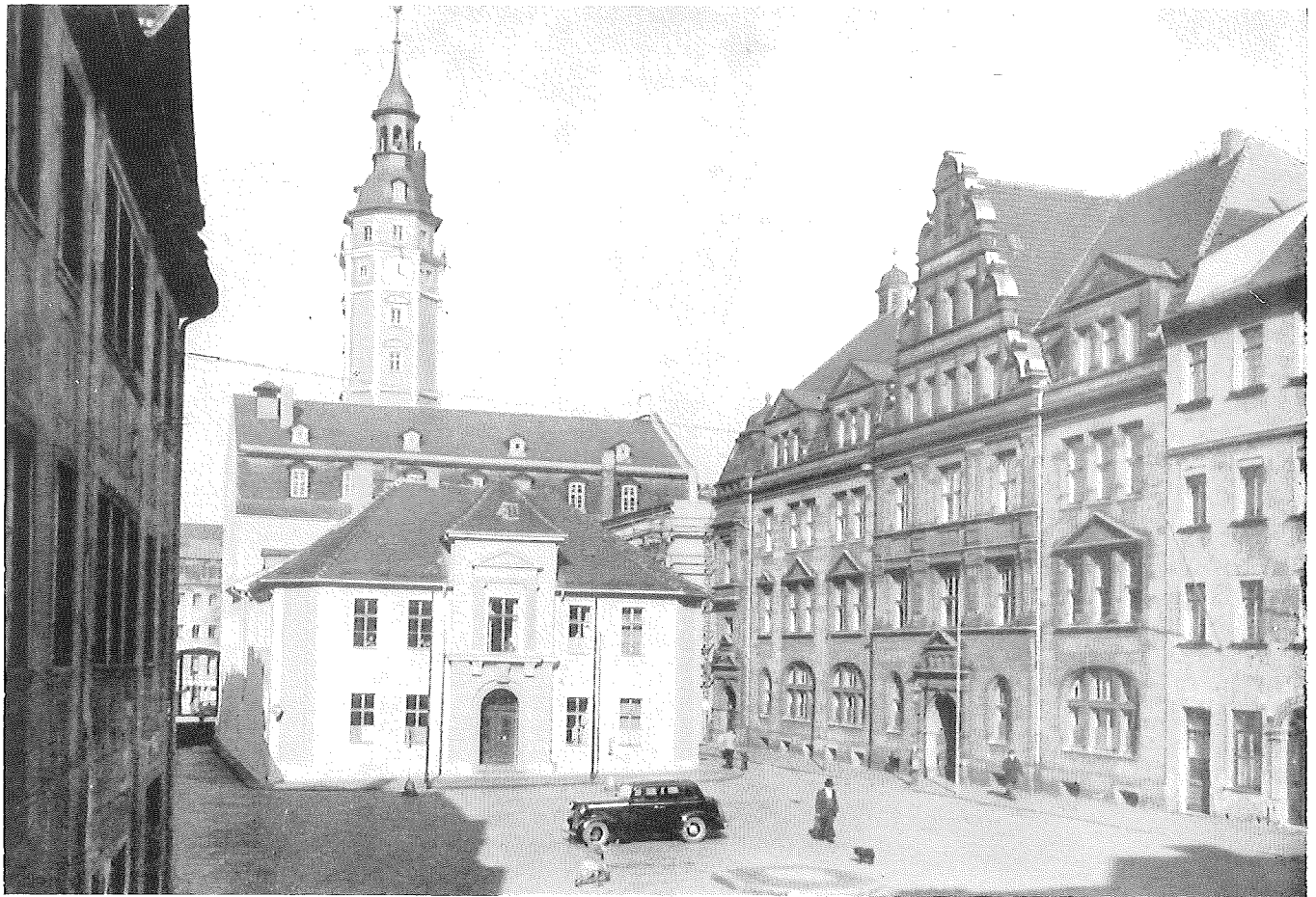
Rückseite des alten Rathauses und Front des neuen im Jahre 1911 erbauten Rathauses mit Nachbildung des alten Badertores als Hauptportal (51)
