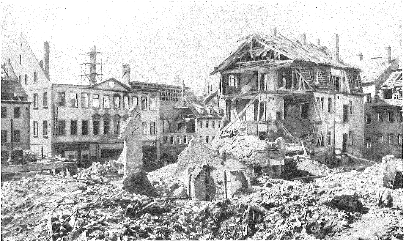
In der schreckensreichen Nacht vom 6. zum 7. April 1945 zerstörten an der oberen Heinrichstraße ( jetzt Josef-Stalin-Straße) Luftminen die am Vortage teilweise vom Brand noch verschont gebliebenen Häuser. (66)
