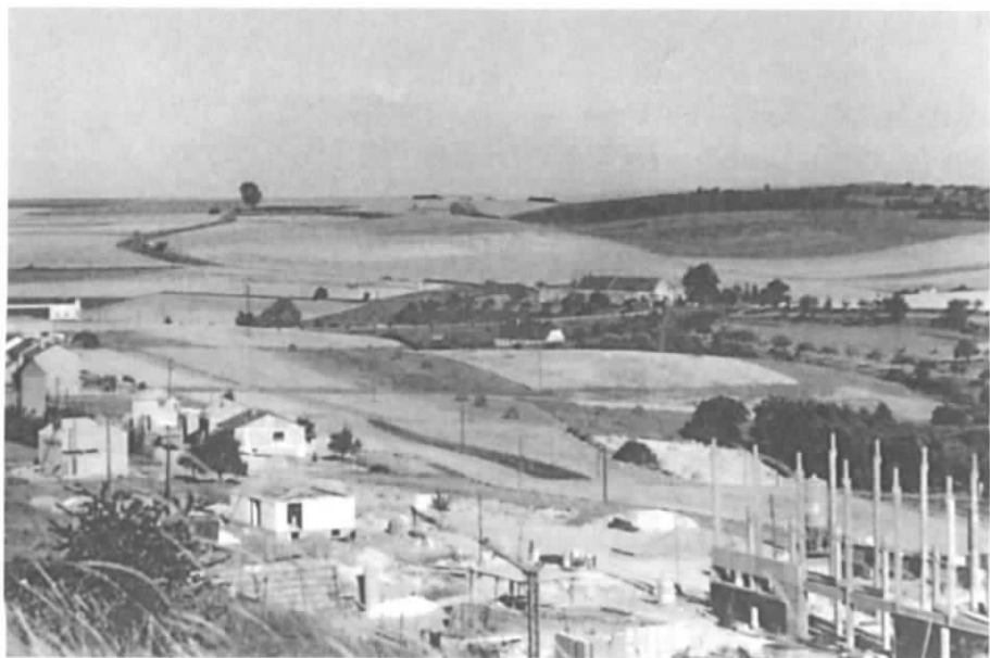
Das neue Gymnasium im Bauzustand (3. 8. 1963)
