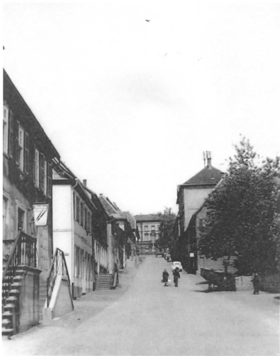
Amtsstraße mit Seitenansicht des Gymnasiums (1955)
